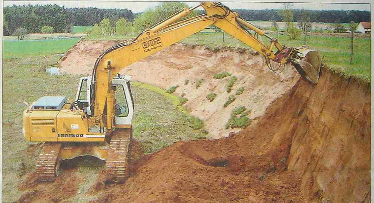
Der Bagger bereitet die Sandwand vor, damit die Uferschwalben ihre Röhren graben können.
