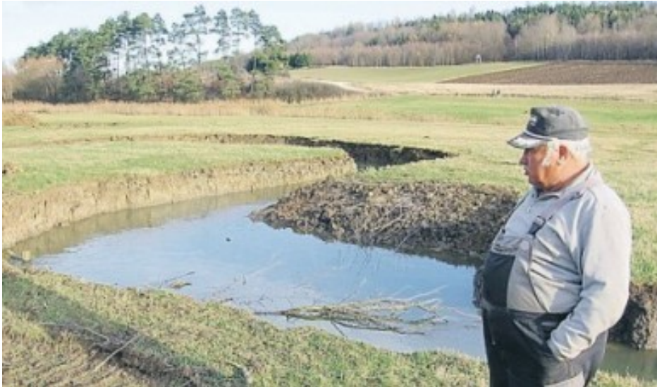
Baggerunternehmer Michael Grimm macht sich ans Werk. Später kann er zufrieden auf die ersten 800 Meter des neuen Flusslaufs blicken. Insgesamt werden 4,5 Kilometer renaturiert. (Fotos: Worm, Engel)
